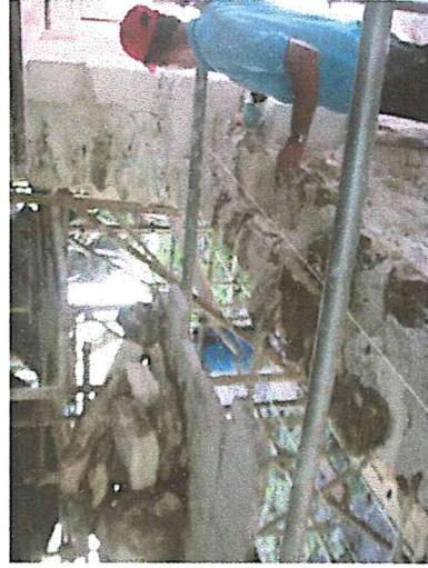
Foto No.3 y 4, Vista del proceso de la restitución de volumen del paramento Oeste, de la cámara sur del edificio 5D.105
