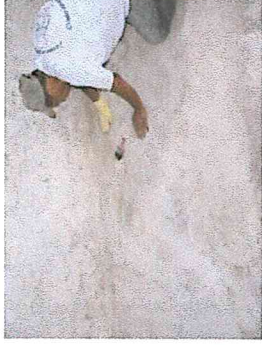
Foto No.47., en proceso de restauración
