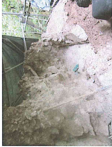
Foto No. 61, excavación en recinto Norte
