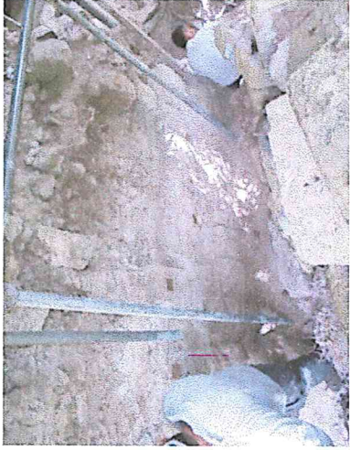
Foto No.51, Vista del desmonte de los sillares
