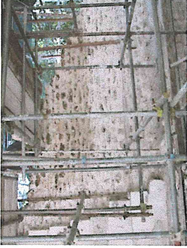
Foto No. 05, vista final de la restitución de volumen en el paramento Oeste de la cámara Sur, del edificio 5D-105.
