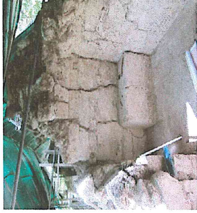
foto No. 62, recinto Norte ya excavado
