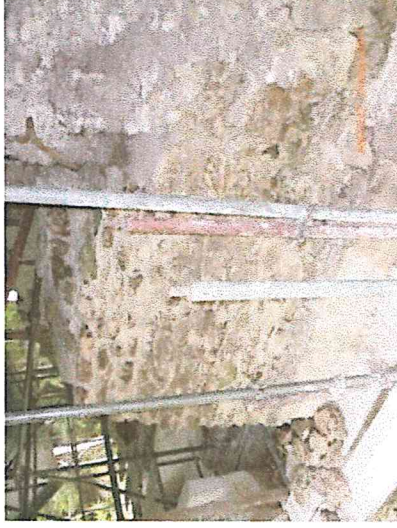
Foto No. 53y 54, Vista del proceso y terminado de restitución de volumen en muro Este exterior entre cámara Sur y cámara Norte.
