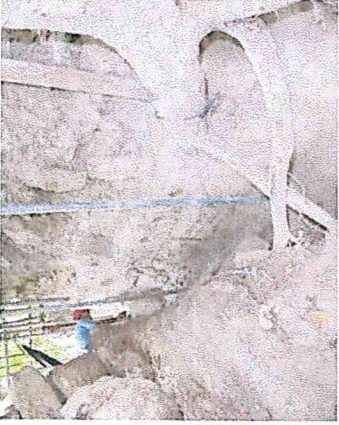
Foto No. 42, Sillares fuera de su lugar original y en mal estado de conservación.
