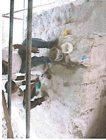
Foto No.34, estado de banca antes de su intervención
