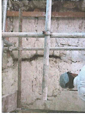
Foto No. 36., Paramento Norte, recinto sur, antes De su Intervención.
